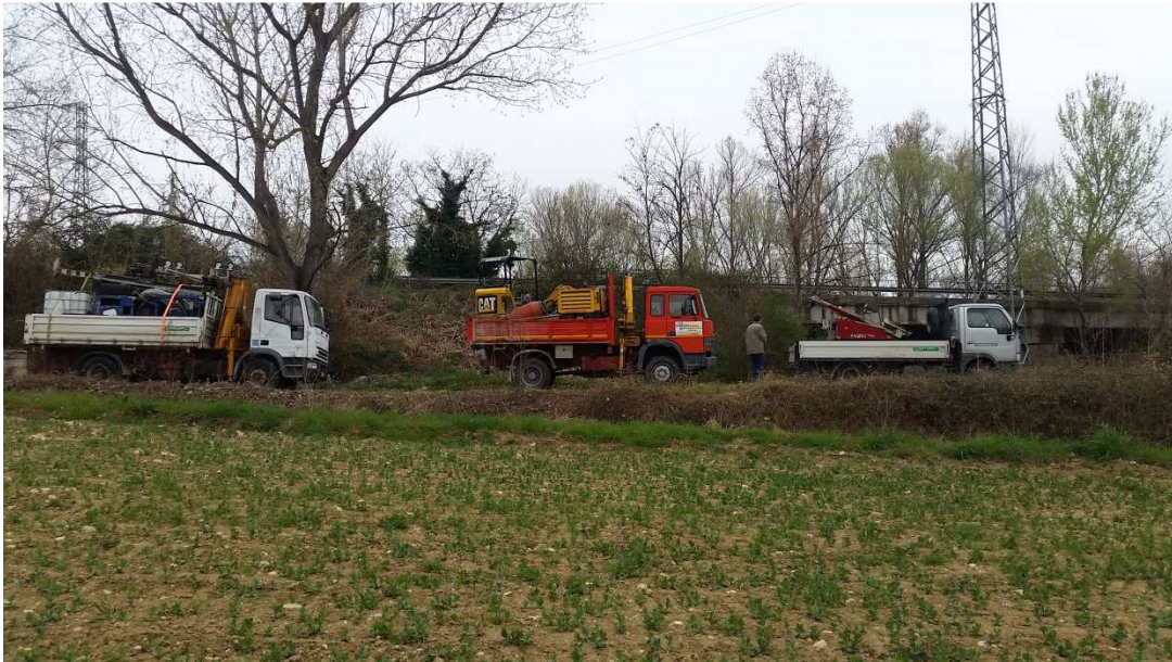
Foto n°1- Approntamento cantiere: Trasporto trivelli a idraulica, escavatore e Penetrometro Pagani TG63-100KN dinamico (DPSH).
