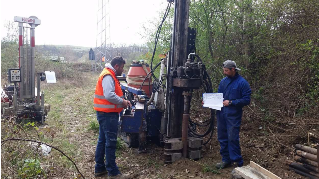
Foto n°5- Postazione Sondaggio geognostico S77
